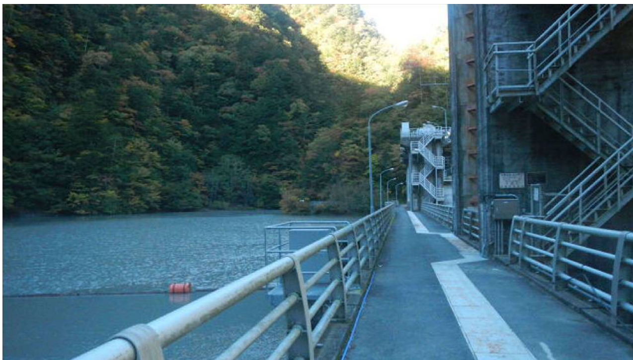
千頭ダム堰堤上の通路。水面が近い。
