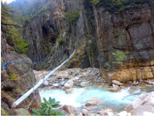
高い第2吊り橋
